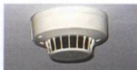
Figura 14: Detector de fumaça, utilizado para acionar o sistema de pressurização de escada de segurança
