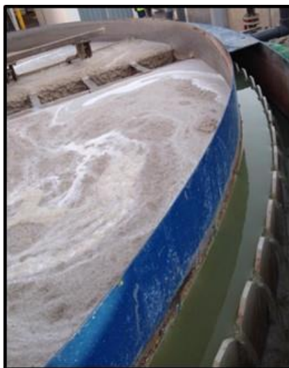
Figura 4.6 - Flotador por ar dissolvido (DAF).
