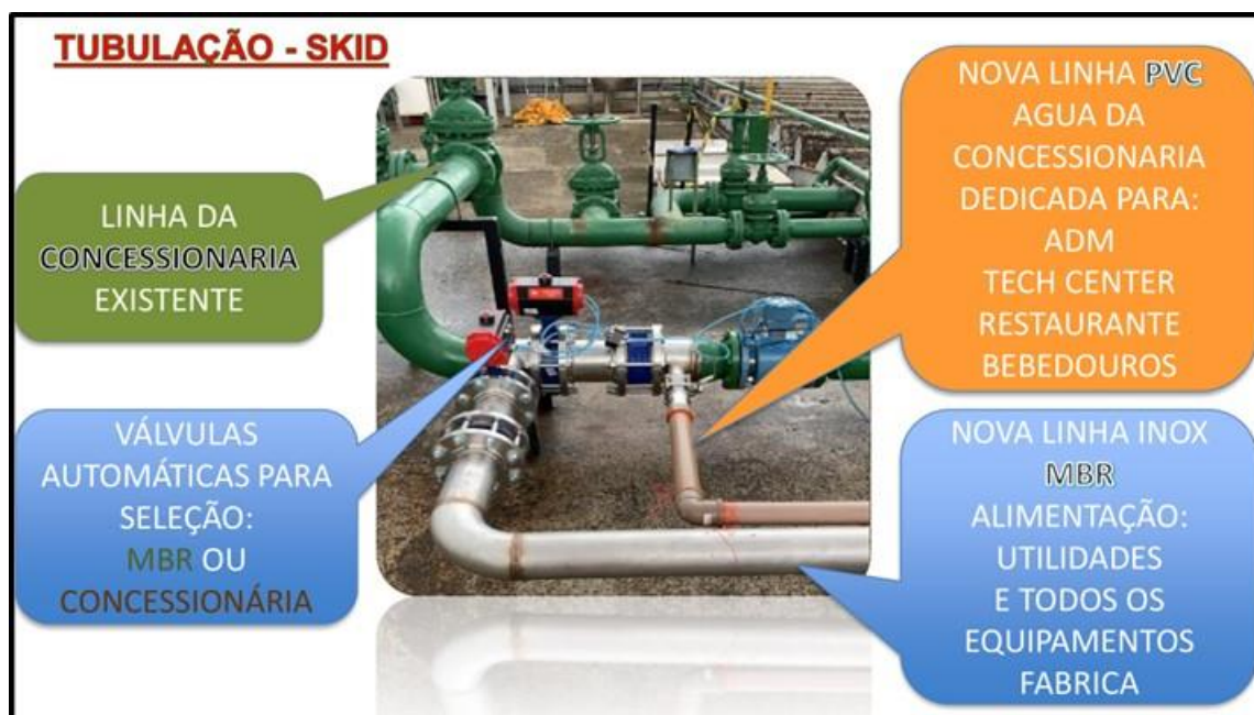
Figura 4.22: Válvula de ajustes/redirecionamento de água. A configuração permite redirecionar água da concessionária para a produção caso o sistema de MBR não consiga atender à demanda.
