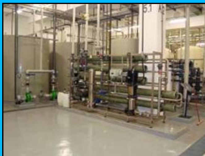
Figura 9: Sistema de Osmose Reversa para recuperação de água da ETE
