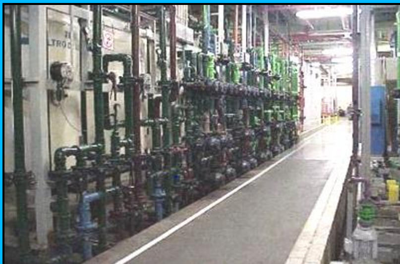
Figura 5: Sistema de troca iônica para recirculação de água da galvanica
