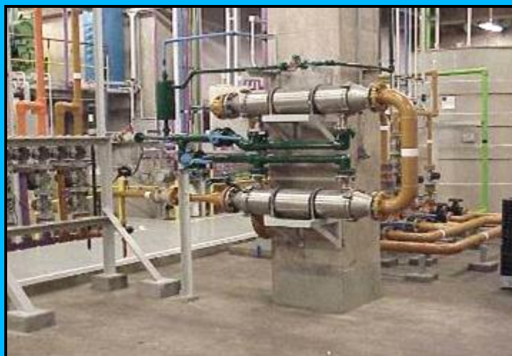
Figura 10: Sistema de Ultrafiltração para quebra de emulsão oleosa
