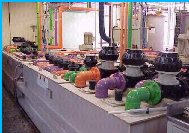
Figura 12: Vista da estação de neutralização de efluentes industriais
