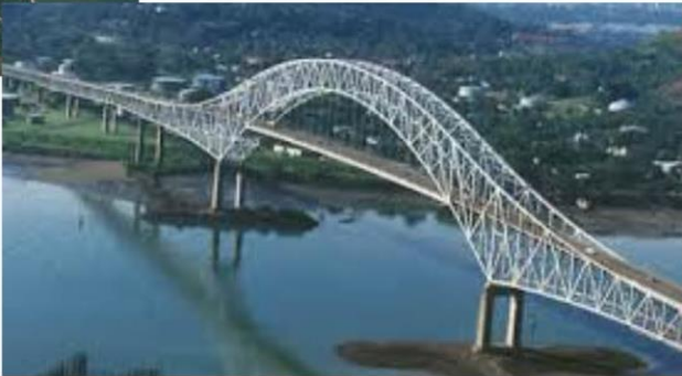
Bridge of Americas Canal do Panamá Calado aéreo máximo 62.48m
