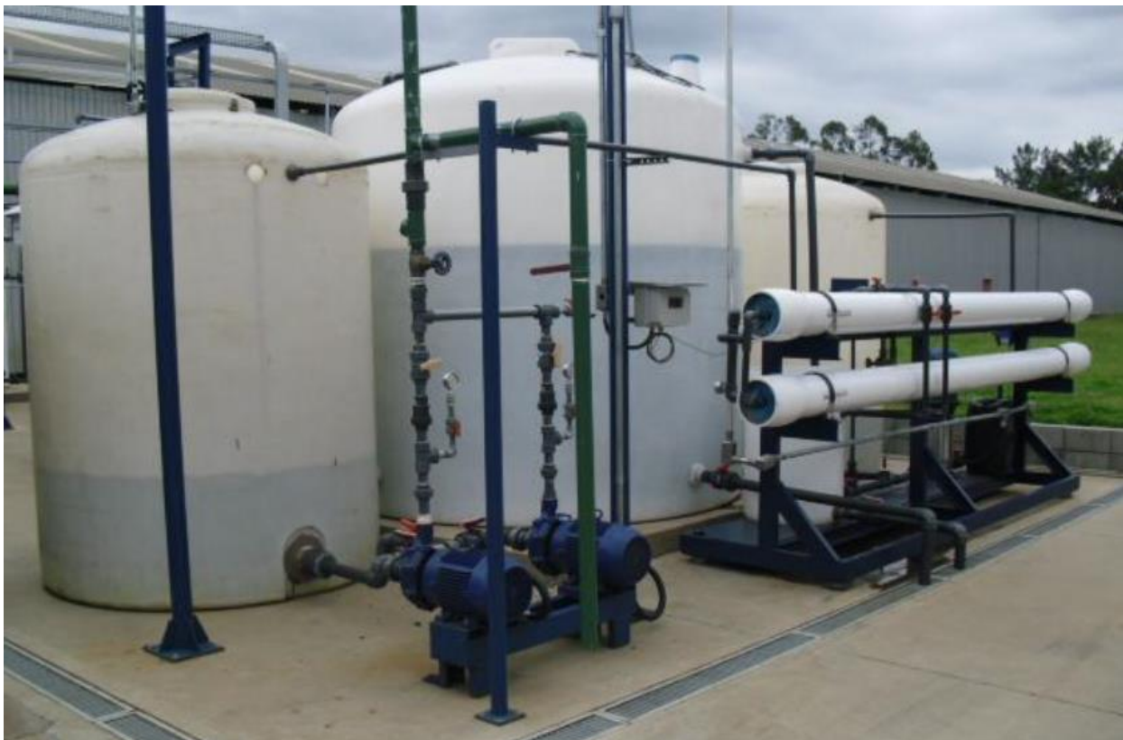
Foto 03: Tanque Equalizadores e Sistema de Osmose
