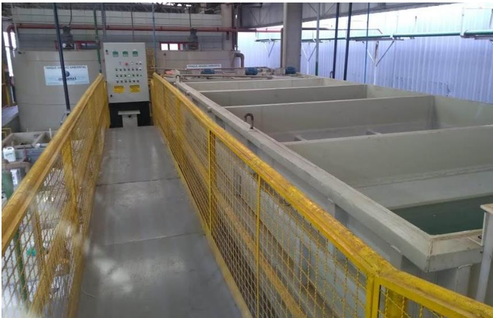
Foto 01: Tanque onde acontece o tratamento Físico Químico
