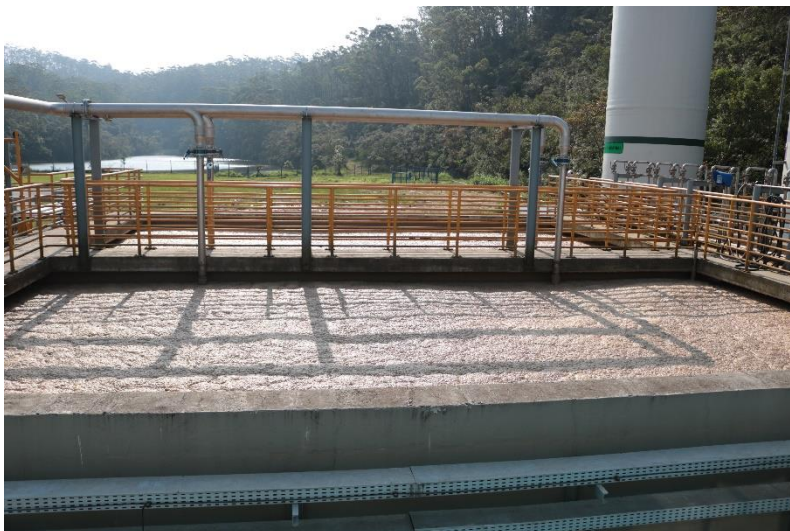
Tanque de Lodo Ativado
