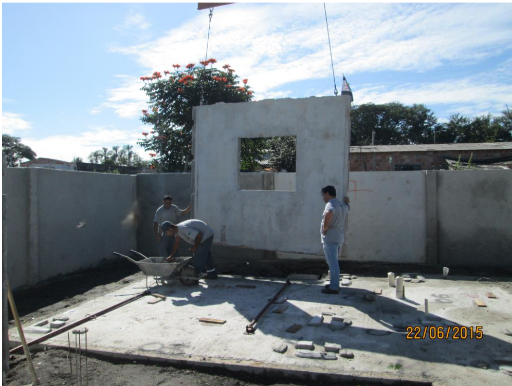
Figura 13: Montagem dos painéis
