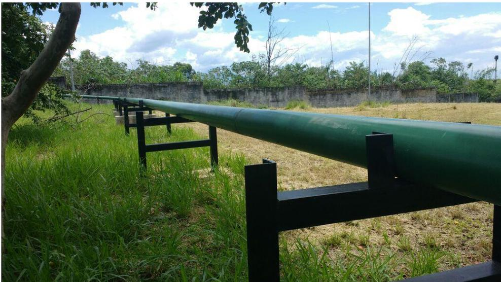
Figura 32 – Novos trechos de tubulação da rede de água industrial
