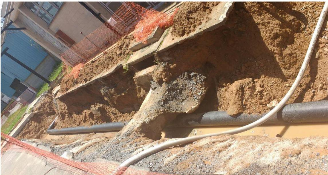
Figura 31 – Novos trechos de tubulação da rede de água industrial
