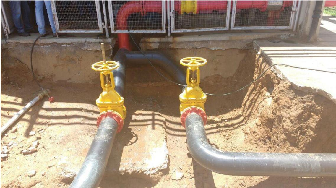
Figura 30 – Novos trechos de tubulação da rede de combate a incêndio
