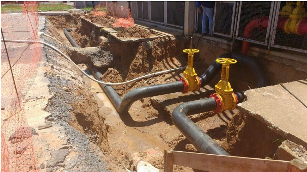
Figura 29 – Novos trechos de tubulação da rede de combate a incêndio
