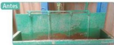
Com o propósito de evitar o desperdício de água na área do Krauss Maffei, na Alumina, uma iniciativa proposta por meio do Fale Fácil, reduziu o consumo no local de forma simples e barata. A bacia de lavagem, usada por todos os empregados da área, possuía 4 saídas de água, porém uma única válvula, que ao ser aberta permitia a saída de água dos 4 pontos, mesmo que só um fosse utilizado. Agora todas as saídas possuem válvulas individuais, que permitem o controle da saída de água de cada uma delas.
