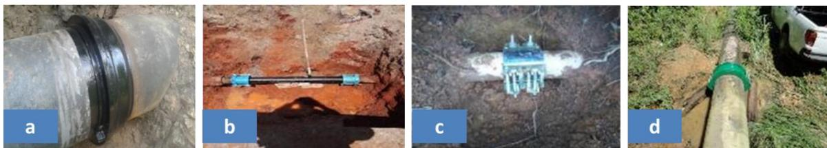
Figura 24: a) Reparo de vazamento com polímero de alta performance. b) Eliminação de vazamento com luva invel. c) Eliminação de vazamento com torniquete. d) Eliminação de vazamento com luva bipartida.
