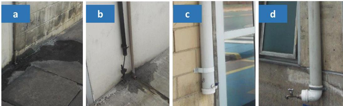
Figura 15: a) e b) Saída de água dos ares-condicionados sem reuso. c) e d) Saída dos ares-condicionados com sistema de reuso de água de baixo custo instalado.
