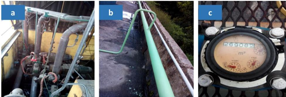
Figura 25: a) Tubulações instaladas para retorno da água. b) Tubulação para trazer a água tratada ao sistema para reuso. c) Hidrômetro para acompanhamento de consumo.
