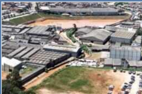
Reservatório AC1 Vila Rosa São Bernardo do Campo
