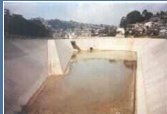
Reservatório AT3a Corumbé Mauá
