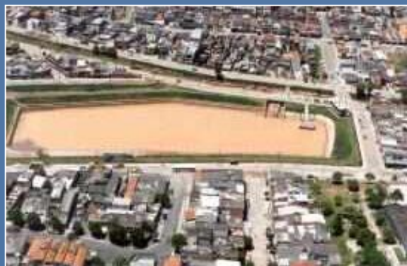
Reservatório TM7 Canarinho Saracantã – S. Bernardo do Campo
