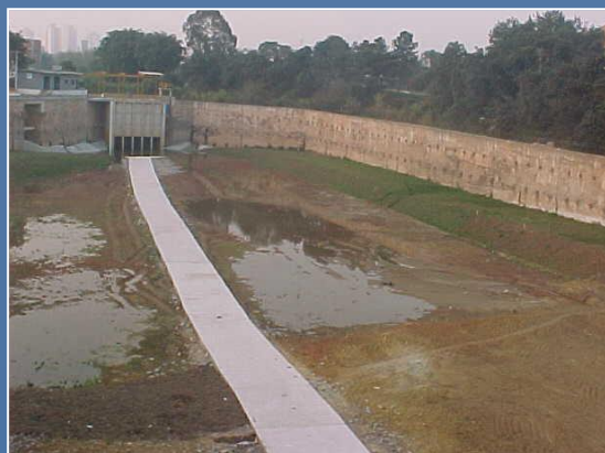
Reservatório TM2 -TM3
