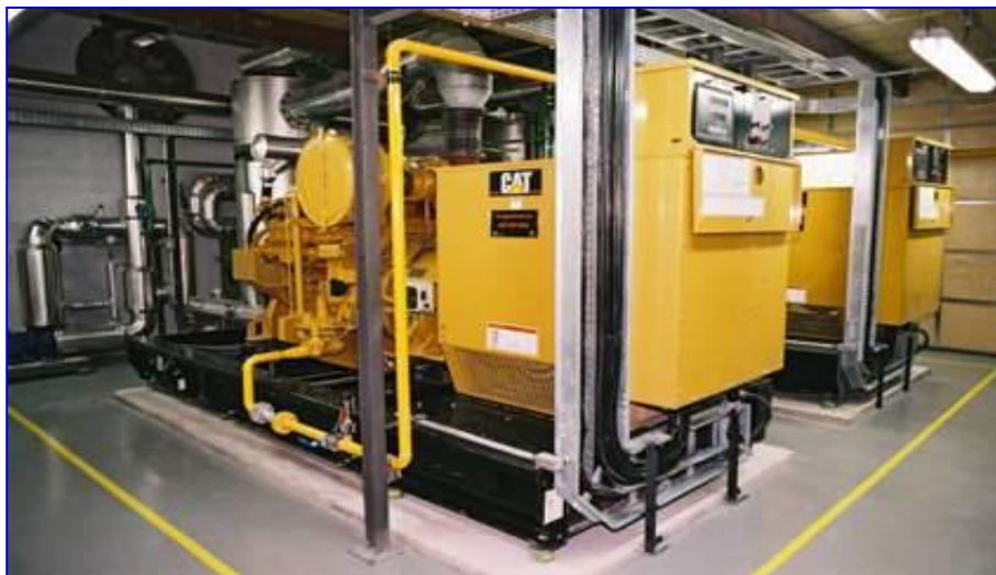
Shopping Center Taboão > Cogen Gas 2 MW > energia elétrica, água quente e água gelada
