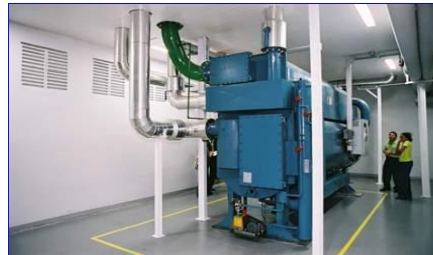
Shopping Center Taboão > Cogen Gas 2 MW > energia elétrica, água quente e água gelada
