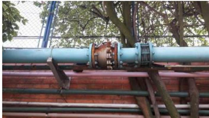
**Figura 6:** válvula de controle de entrada de ar nas fábricas
