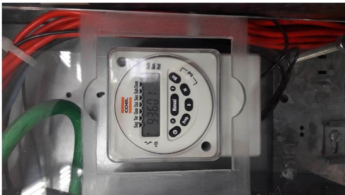
**Figura 14:** timer dos equipamentos de ar condicionado
