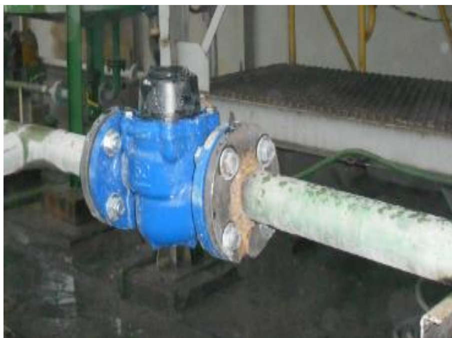
Figura 4 - Hidrômetros na Torre de Arrefecimento e Fase de Cimento
