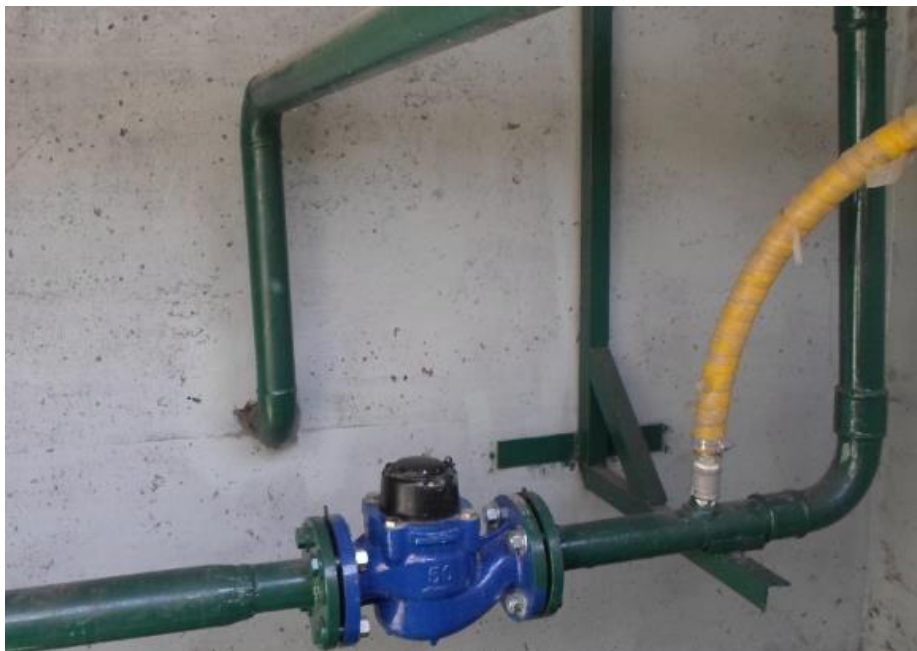
Figura 5 - Hidrômetros na Torre de Arrefecimento e Fase de Cimento
