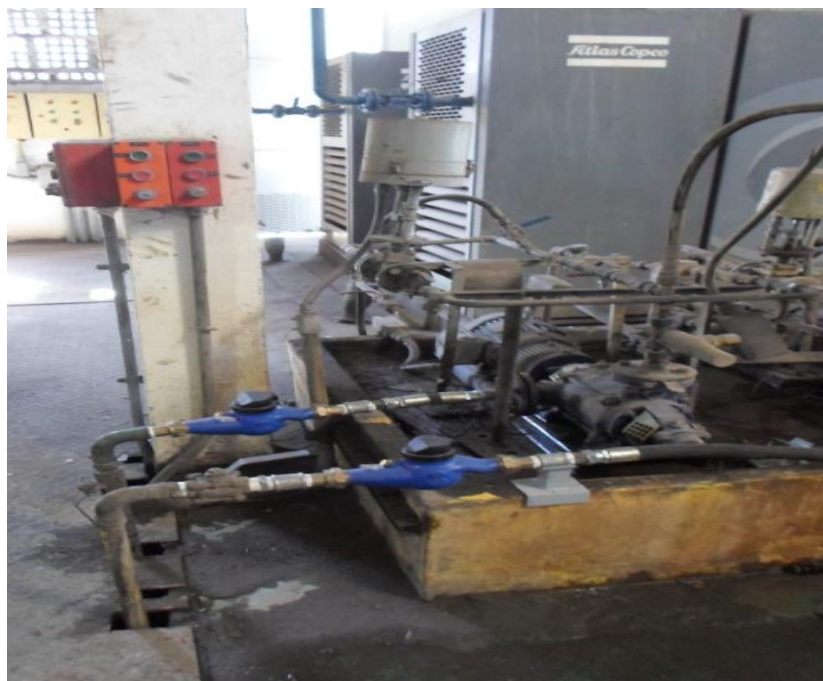
Figura 3 – Hidrômetros da Fase de Cimento
