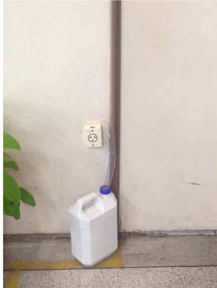
Essa reutilização também se estende para os aparelhos de ar condicionado, onde é reaproveitada a água condensa no aparelho, captada por bandeja e conduzida por mangueira em um galão de 5 litros. A utilização desta água destina-se para irrigação dos vasos de plantas existentes nas áreas
