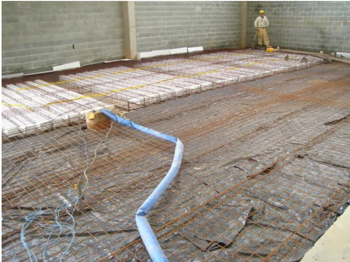
Fechamento da parte superior da caixa de captação
