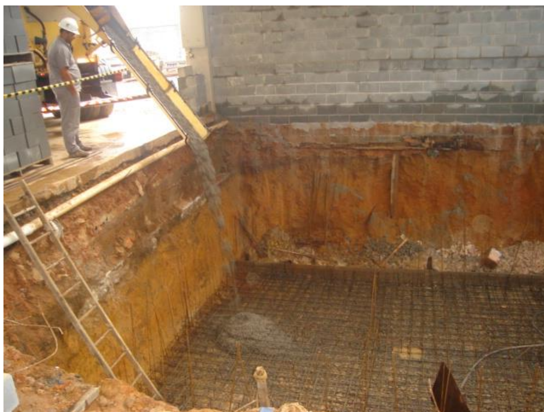
Construção da caixa de captação de água de chuva
