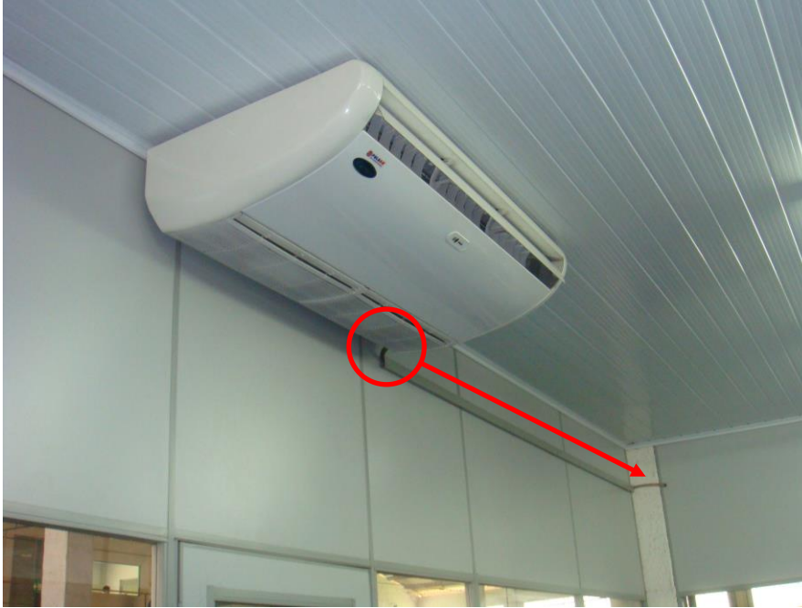
Foto 01 – Indica o caminho da tubulação criada.
