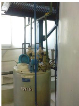
Tanque (Flocculante)
