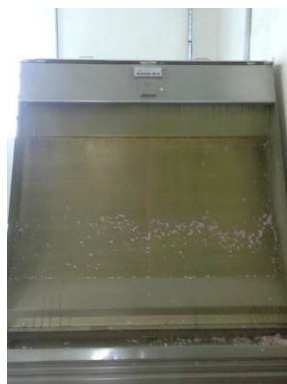
Sistema de Peneira de Retirada de Fiapos
