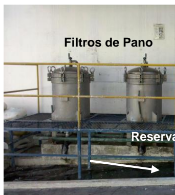
Sistema de filtragem de água para reuso
