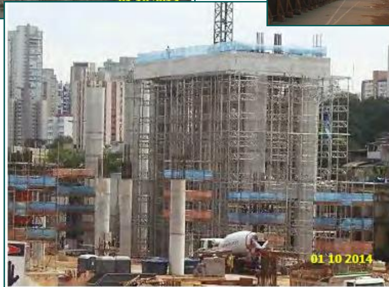
Pátio Água Espraiada: pilares em execução
