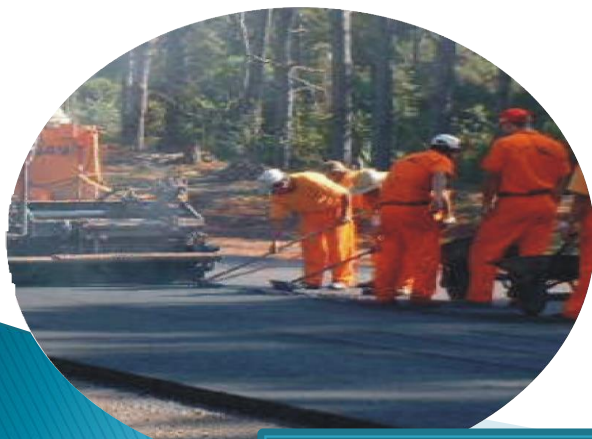
Sub Base Asfáltica
