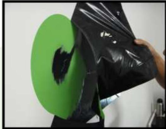
**Figura 18.** Retirada do adesivo-molde a após a secagem das tintas.
