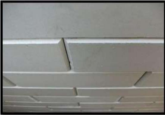
**Figura 09.** Prumo de alvenaria a base de fosfogesso (Novogesso). **Fonte:** Inovamat, 2012.
