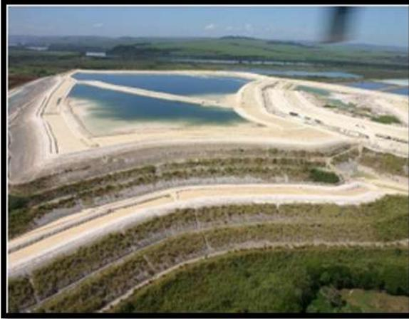
**Figura 03.** Lagoas de sedimentação disposto a úmido. **Fonte:** Fosfertil
