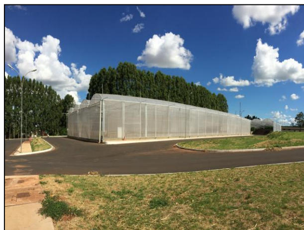
Vista ampla do empreendimento
