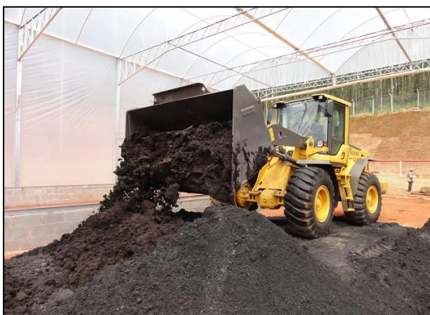
Trator realizando carregamento de lodo
