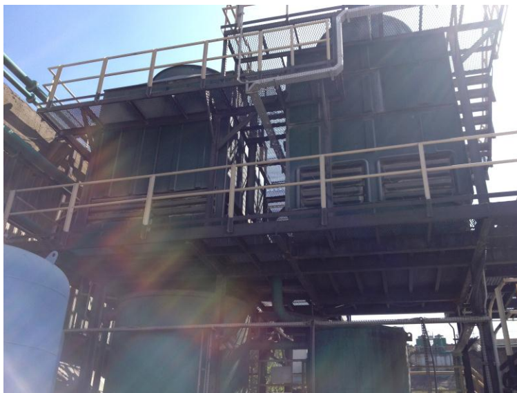
Figura 2: Exemplo de sistema de resfriamento de recirculação aberta considerado no emprego de águas de refrigeração de laminadores, trocadores de calor, fornos, retíficas, entre outros.
