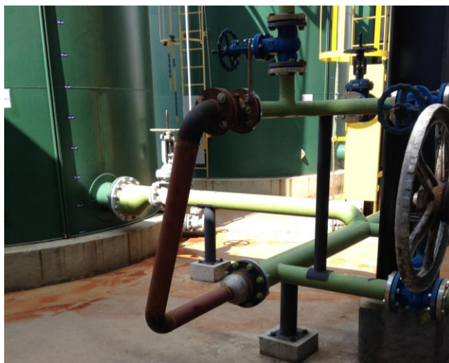
Figura 5: Exemplo típico de reaproveitamento de água via recirculação, minimizando perdas por descarte.
