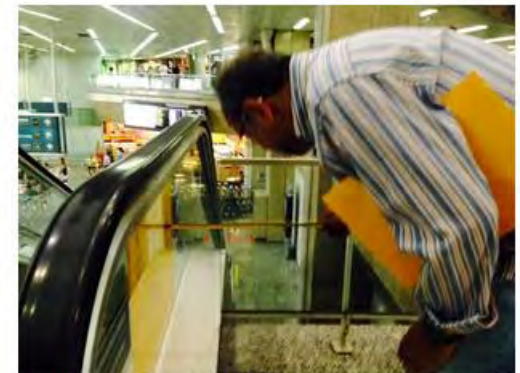
Área marcada: engenheiro constata que vão do guarda-corpo do aeroporto de Galeão está fora dos padrões (Foto: Guilherme Brito/G1)
