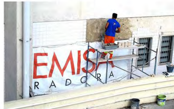
Argamassa ruim faz azulejos despencarem no estádio. Operário recoloca (Foto: Fabio Leme)
