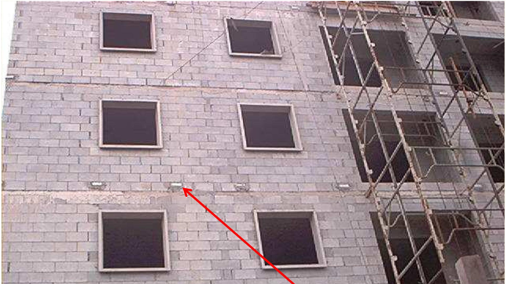
Posicionamento e fixação dos contramarcos durante a elevação da parede: **referencial** para o **revestimento**
