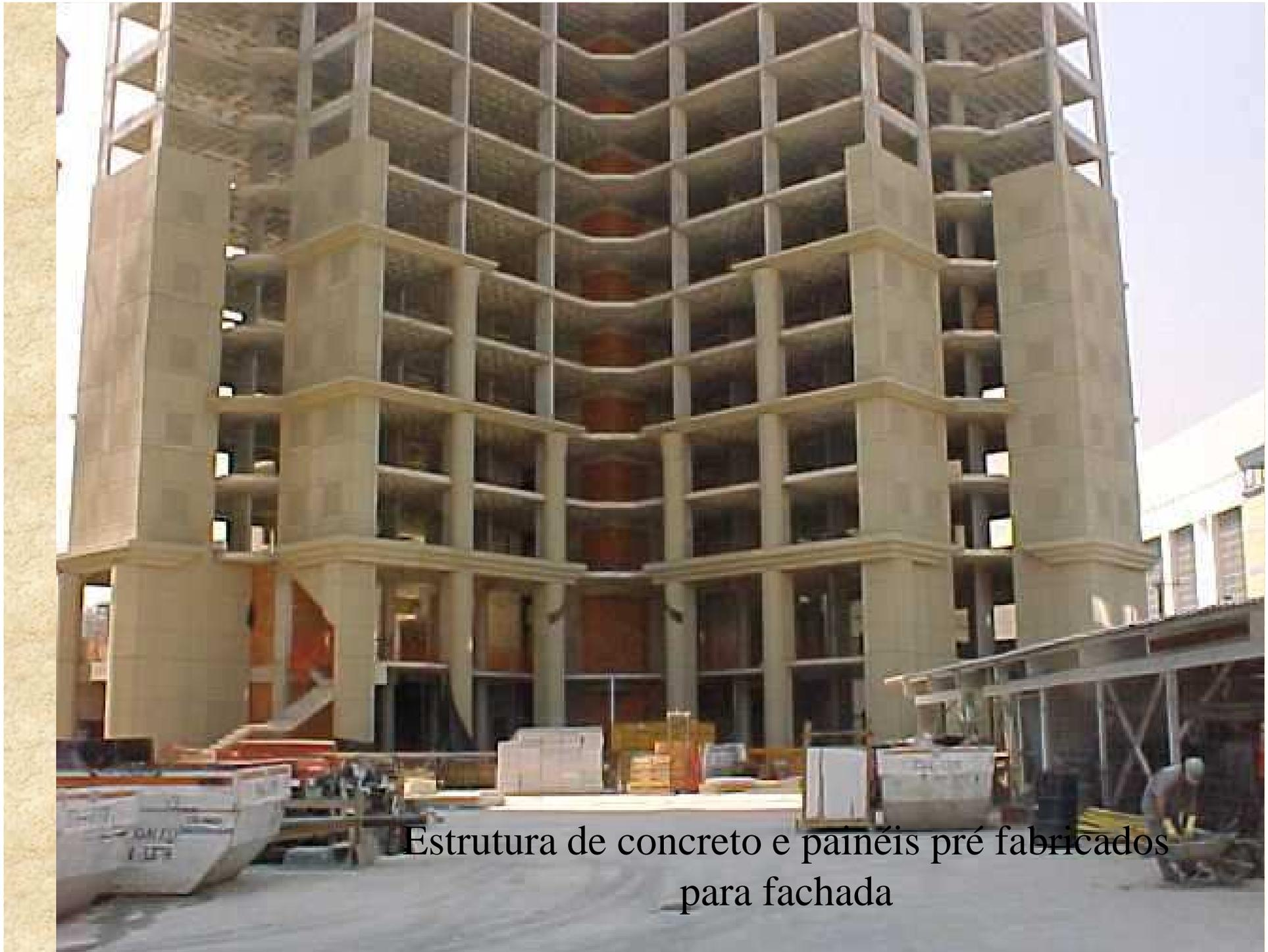
Estrutura de concreto e painéis pré fabricados para fachada
