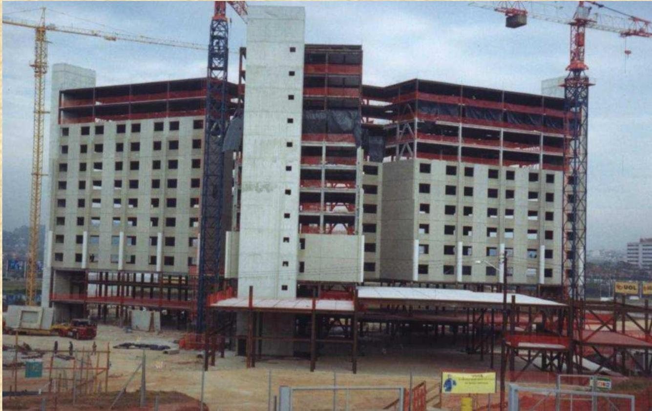
Processo Impar – estrutura em aço e vedações em painéis arquitetônicos de fachada e divisórias de gesso acartonado
