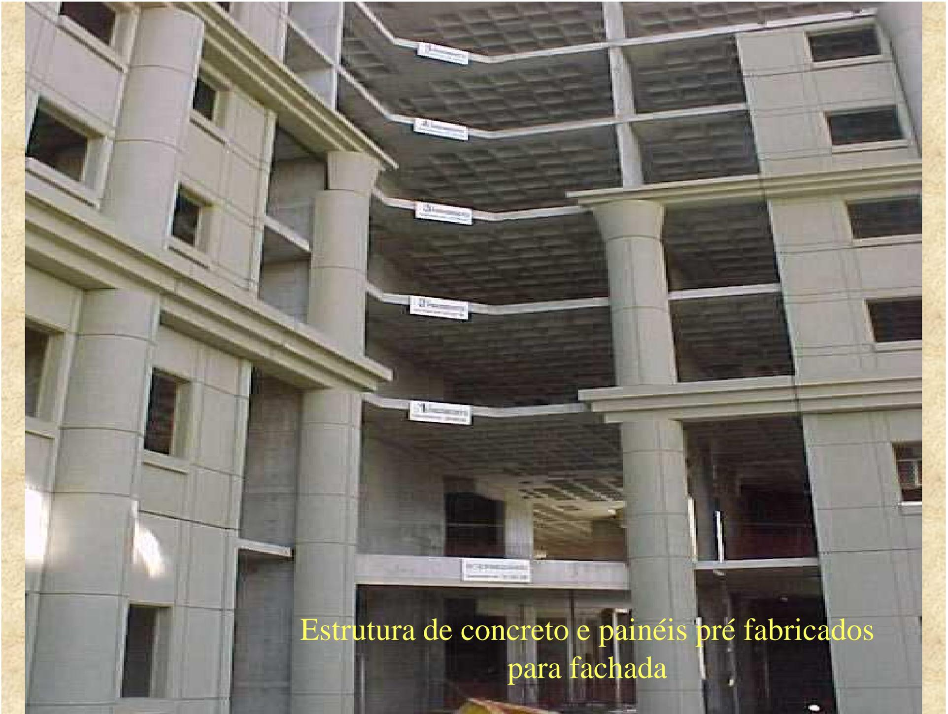
Estrutura de concreto e painéis pré fabricados
