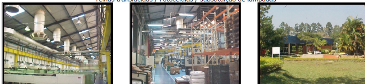
Figura 5: Telhas translúcidas, fotocélulas e substituição de lâmpadas.
