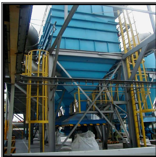
Figura 10: Sistema de filtros na área externa.
