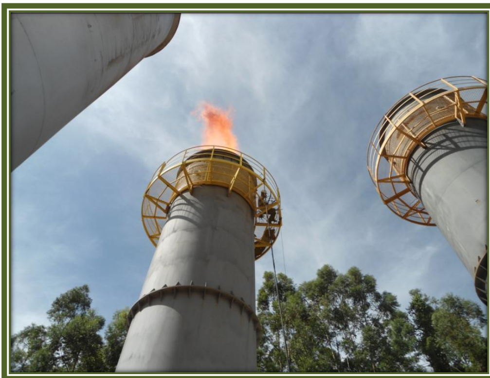
Figura 4 – Tubos de queima do Biogás
