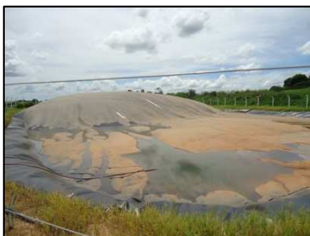
Figura 4 - Lagoa já com a geomembrana.
