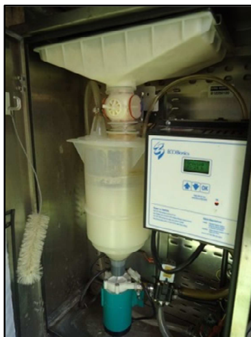
Figura 6 - Equipamento responsável pelo lançamento diário das bactérias anaeróbicas no sistema do biodigestor.
