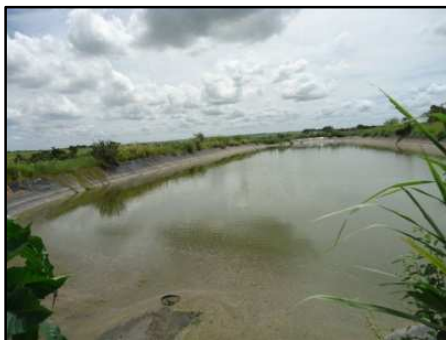
Figura 4 - Lagoa já com a geomembrana.
