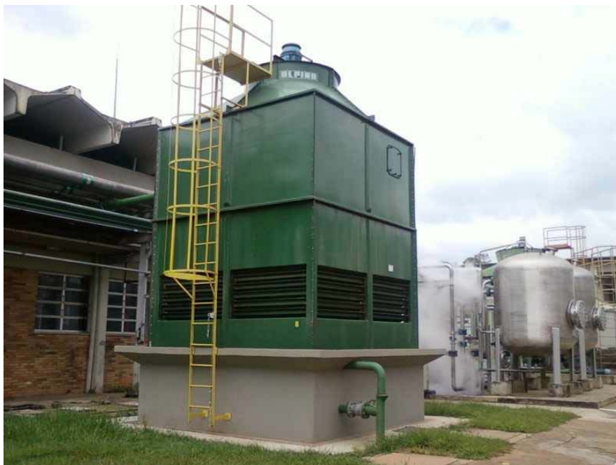
Torre de resfriamento - Linha de envase de refrigerante
