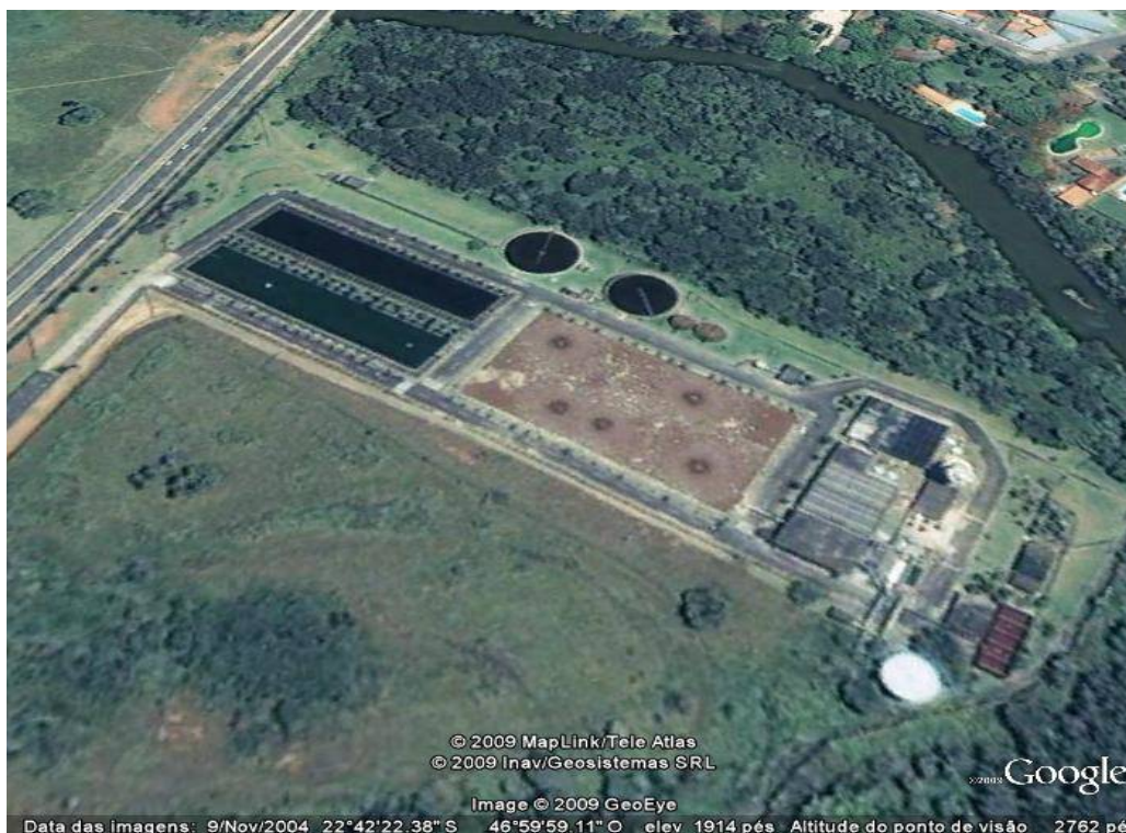
ETEI - Estação de tratamento de efluentes industriais
