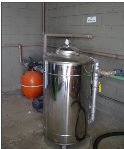
Figura 5.3 Filtros de areia e aparência límpida da água de reuso.
