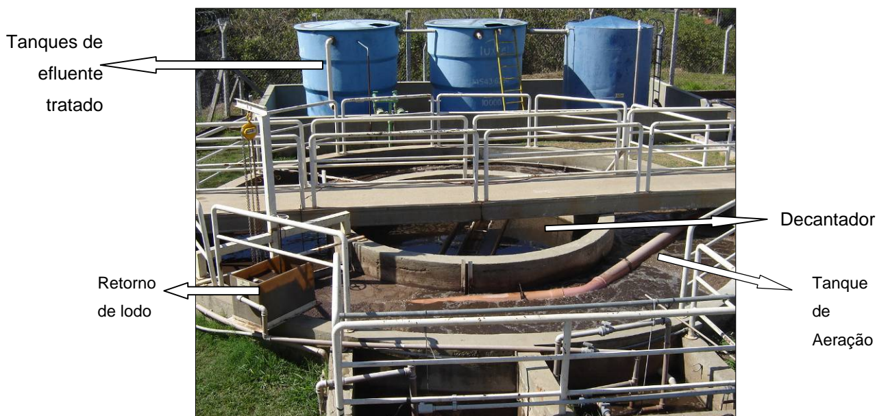
Figura 5.2 Estação de Tratamento de Efluente Biológico.
