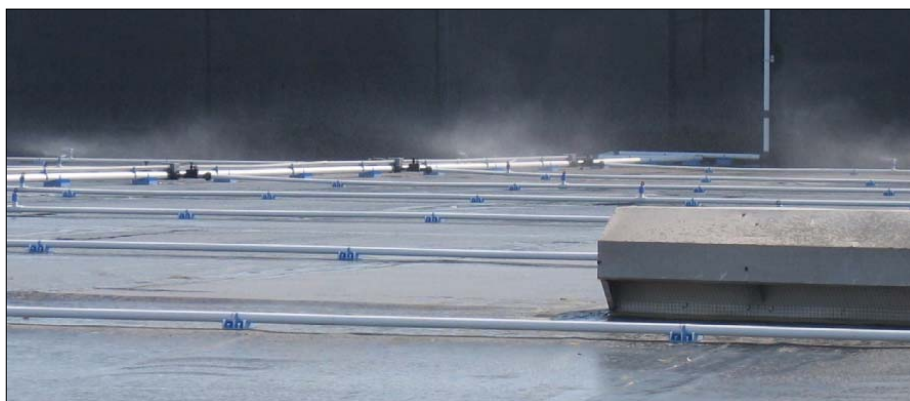
Figura 5.6 Foto ilustrativa da distribuição de micro aspersores sobre telhado.
