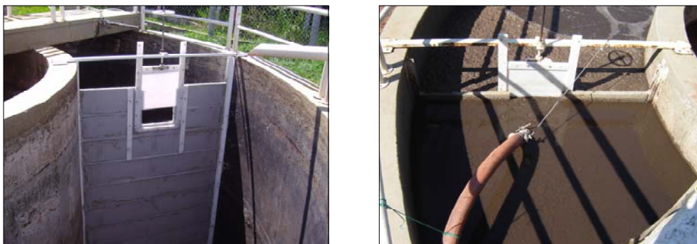
Figura 5.1 Construção e uso zona anóxica do processo de tratamento.
