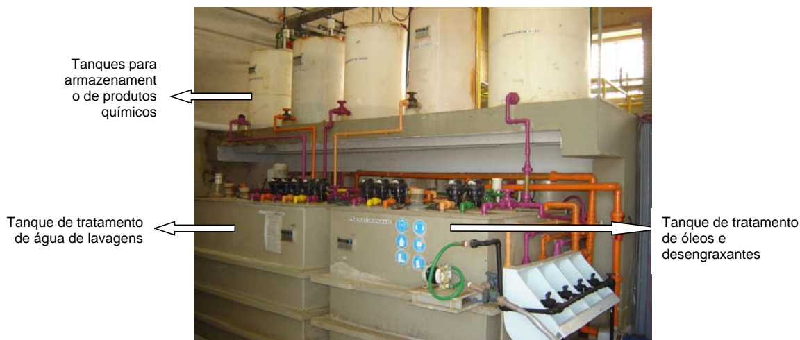
Figura 5.4 Estação de tratamento de efluentes industriais.
