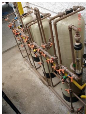
Figura 39 – Reator de trocas iônicas para descontaminação final do filtrado da água após filtro-prensa
