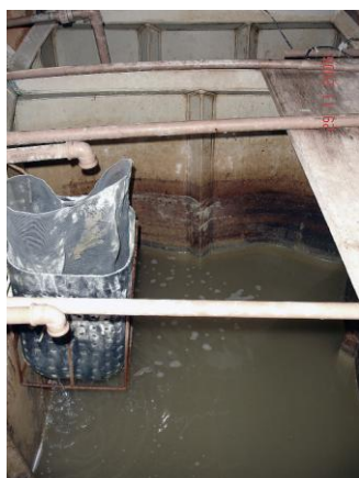
Figura 35 Tanque receptor de efluente bruto na ETE-G
