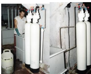
Linha de Cobre Cianídrico rotativa – reator de troca iônica para remoção de Cianetos e Cobre
