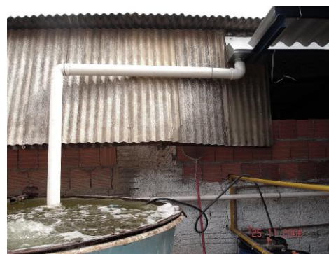
Figura 40 – Reservatório de 5m 3 para armazenagem da água de reuso e captação para reuso de água de chuva
