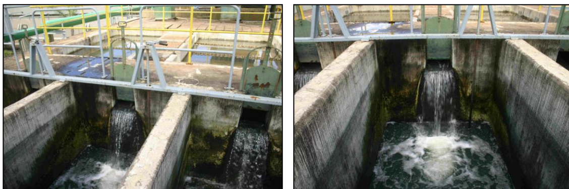
Figura 21: Caixa de Filtro de Areia da ETA 2
