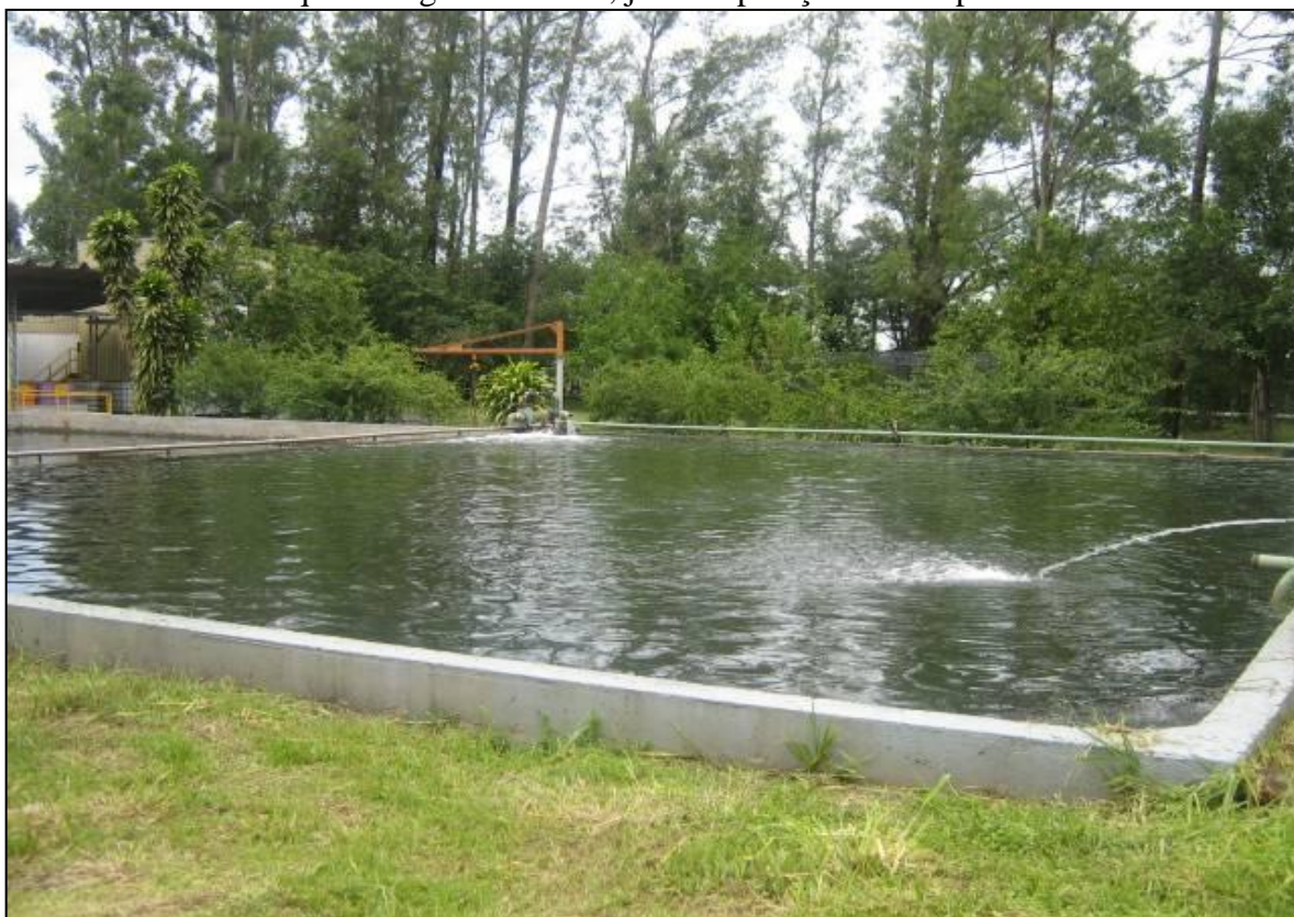
Foto 2 – Tanque de Água de Reuso, já em Operação com capacidade de 300 m 3 .
