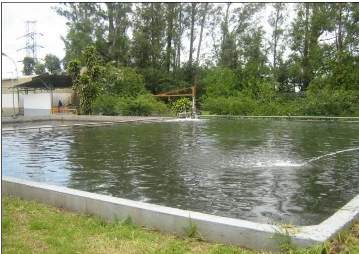
Foto 1 – Tanque de Água de Reuso, já em Operação com capacidade de 300 m 3 .
