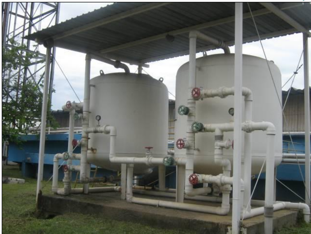
Foto 3 – Filtro de Areia e Carvão Ativado utilizado para o tratamento final da água para o reuso.
