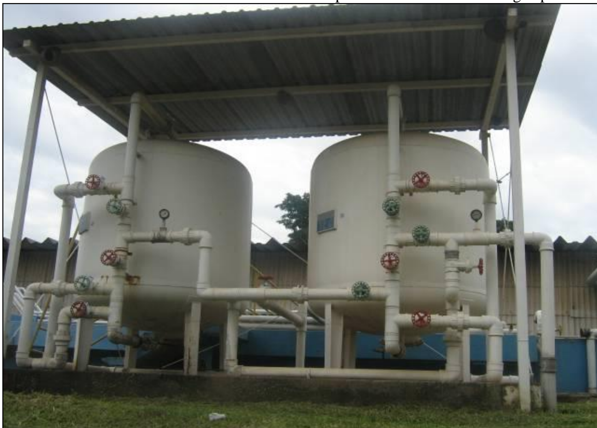
Foto 4 - Filtro de Areia e Carvão Ativado já em operação
