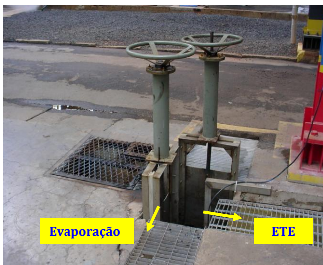
Figura 8 – Detalhe do sistema de coleta e destinação de condensados
