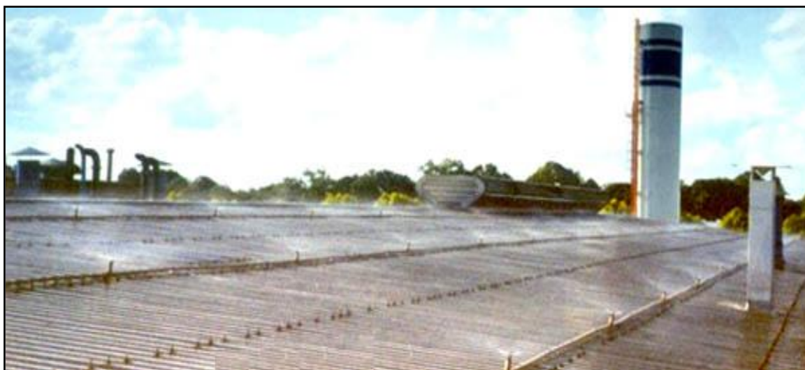
Figura 06: Telhado com Aspersores de Água
