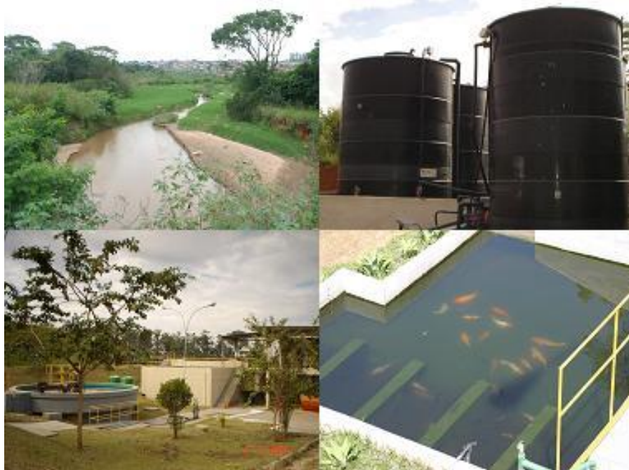
Figura 10 - Central de Tratamento de Efluentes MABE
