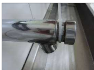
Abraçadeira de nylon - 4 mm de espessura
