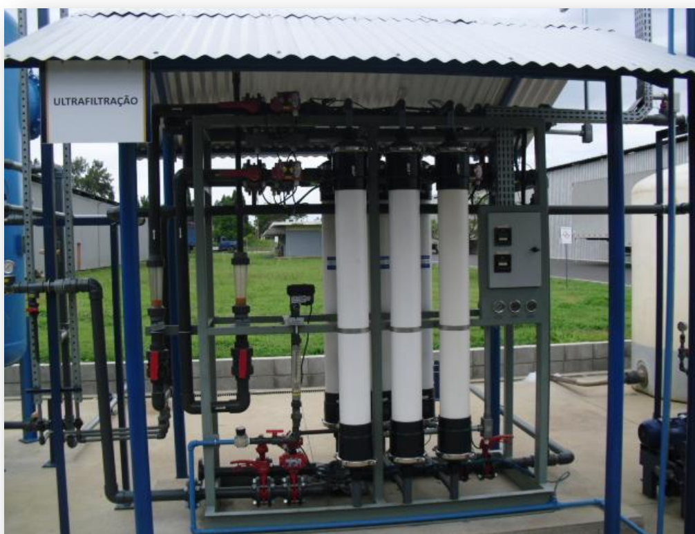
Foto 7: Vista do sistema de ultrafiltração
