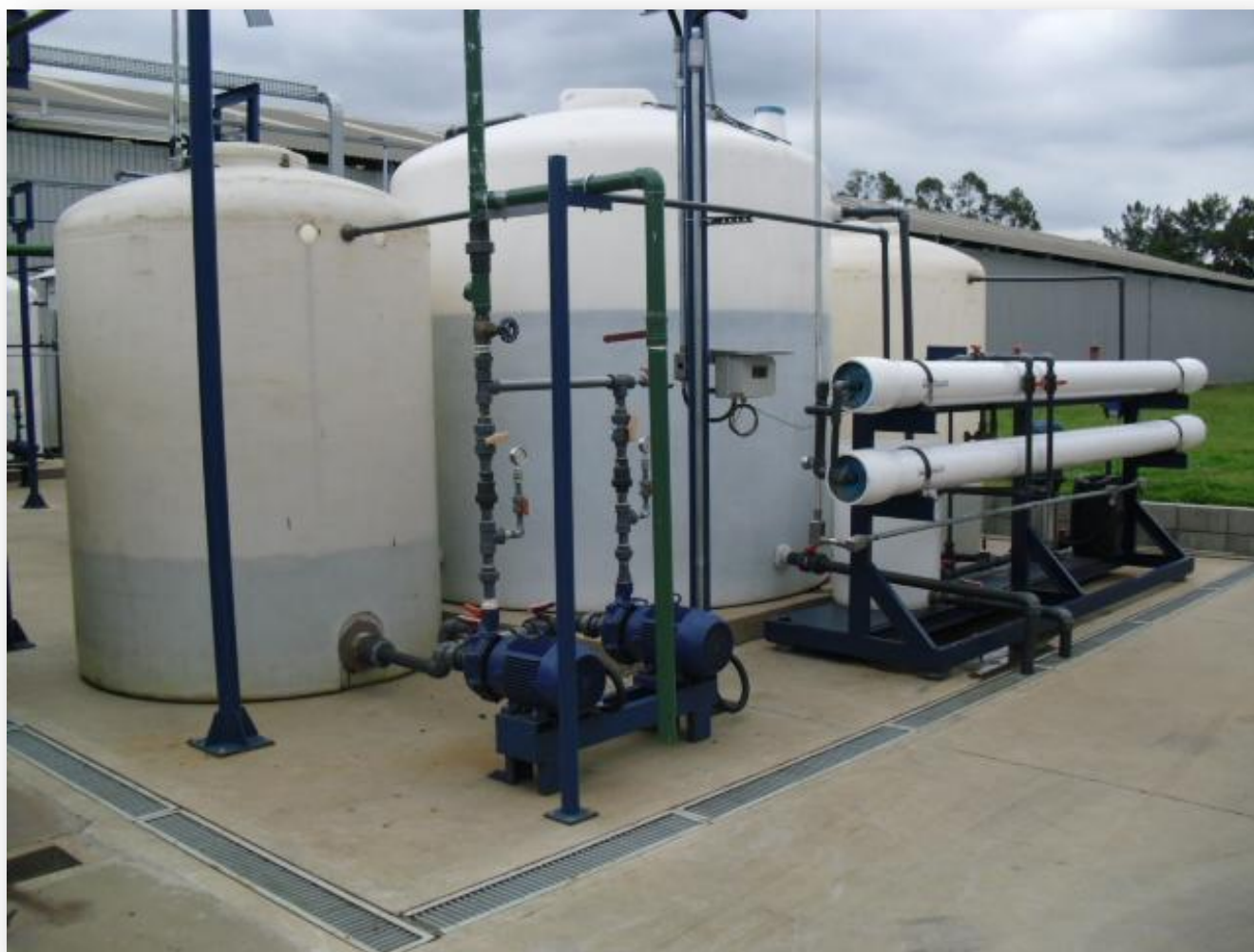
Foto 8: Vista do tanque pulmão de 20 m 3 , tanques reservas e sistema de osmose reversa.
