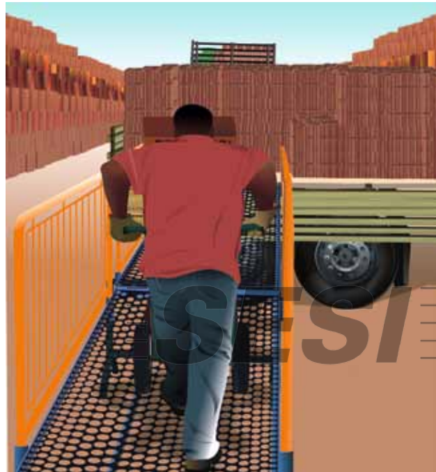
Figura 44 | Rampa portátil
