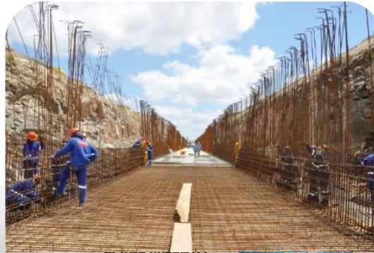
Canal de Saneamento Básico - Trecho IV - Execução de Canal Retangular
