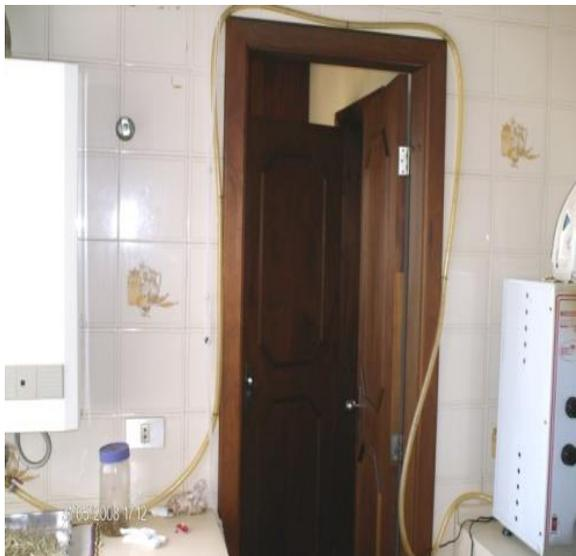
**Figura 27 - Instalação de aparelho a gás com mangueira plástica**
