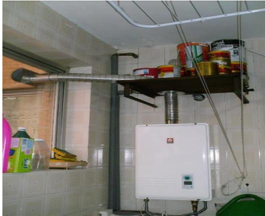
**Figura 24 - Material Inflamável próximo a saída de chaminé**
