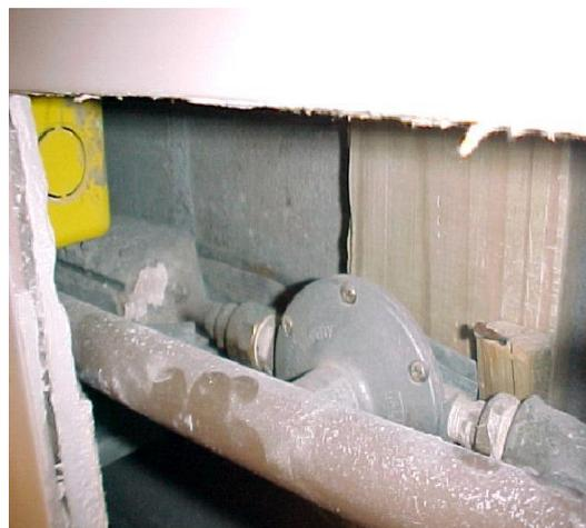
**Figura 26 - Regulador e tubulação instalada em Dry Wall**
