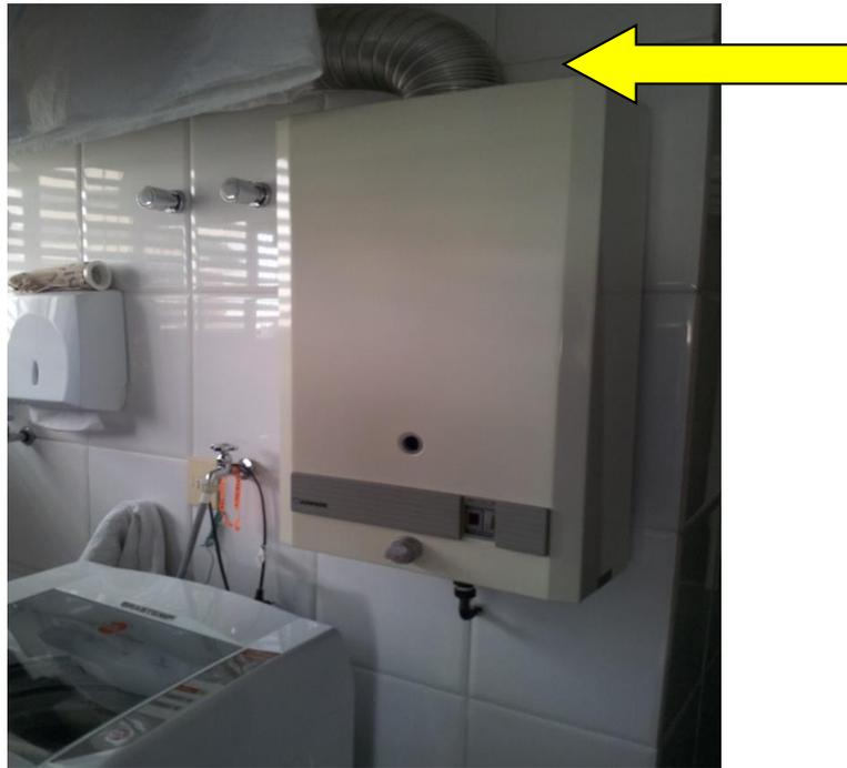
**Figura 19 - Aquecedor de Passagem – Curvatura de duto de chaminé inadequado**
