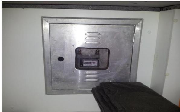
**Figura 22 – Local de instalação de medidor em local sem ventilação e com acesso restrito**
