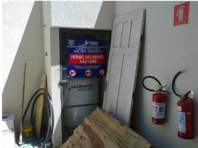
**Figura 28 - Material inflamável próximo aos tanques de GLP**
