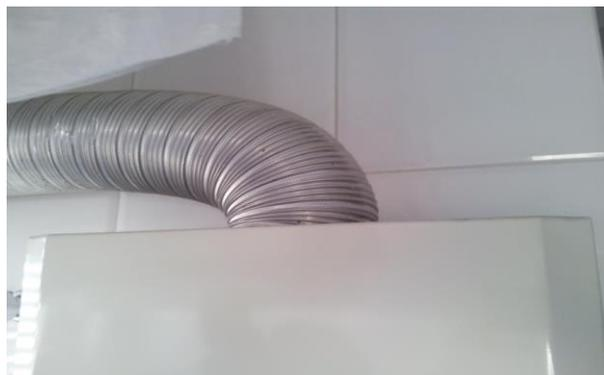
**Figura 20 - Não atendimento à condição de instalação de chaminé**
