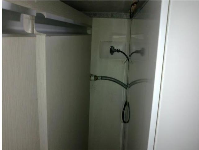
**Figura 29 - Válvula em local restrito e próximo a ponto de eletricidade**
