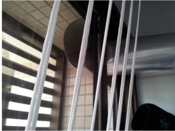
**Figura 21 – Terminação que deveria ser externa instalada internamente ao AP**
