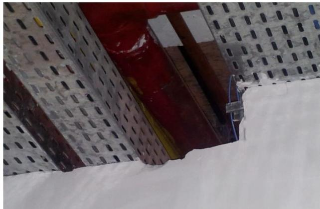
**Figura 18 - Tubulação embutida em Dry Wall com potencial confinamento**
